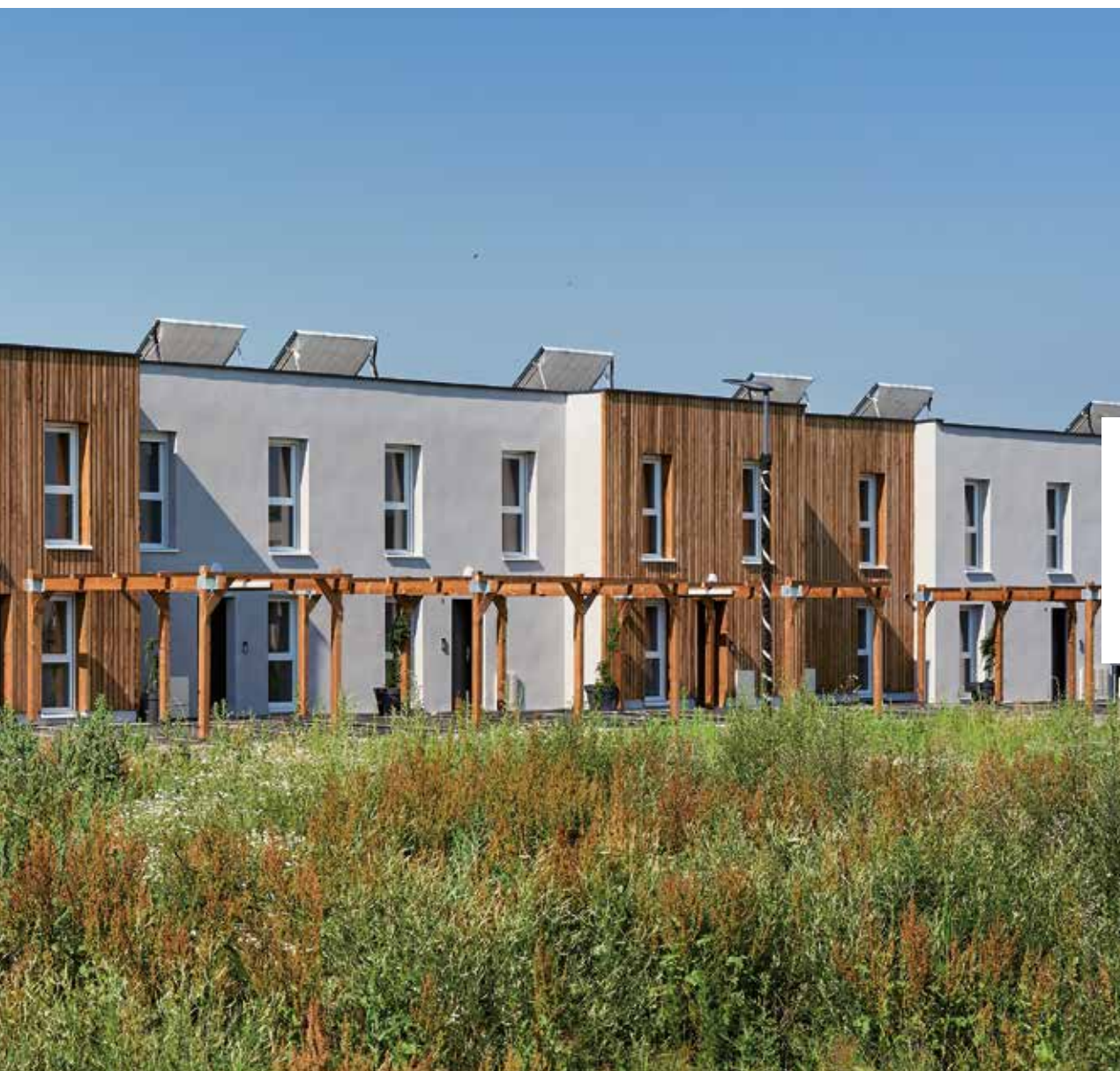
Construction d'un bâtiment de 14 logements en duplex avec terrasses et jardins.
